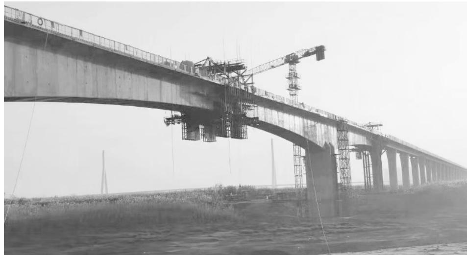
12月28日1:28，随着最后一车混凝土泵送完毕，由中铁十一局集团承建的武汉地铁16号线沌口项目跨通顺河(75+125+75)m连续刚构中跨合拢段顺利浇筑完成，此举标志着跨通顺河连续刚构顺利合拢。
