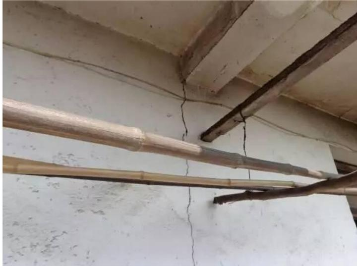
图 3.4.1 (c) 支承大梁的墙体出现缝宽大于 1.0mm 的竖向裂缝
