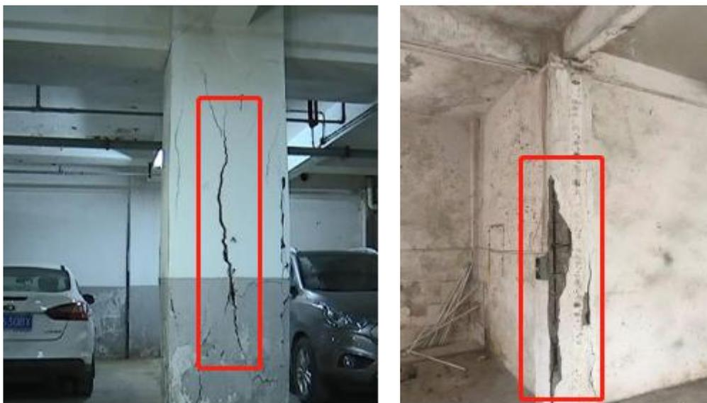
图 3.4.6 (c) 柱有竖向裂缝，或钢筋外露、锈蚀
