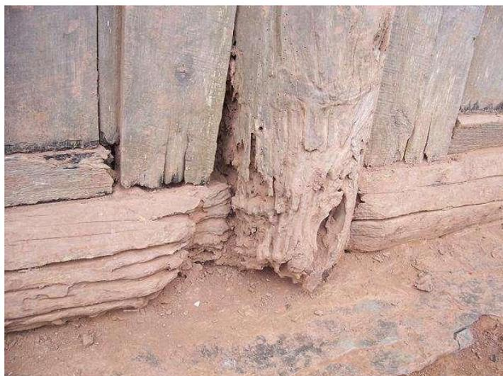
图 3.4.4 (b) 木柱柱脚严重腐朽
