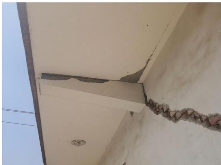
图 3.4.1 (e-2) 悬挑构件相连墙体出现宽度大于 0.5mm 的通长裂缝
