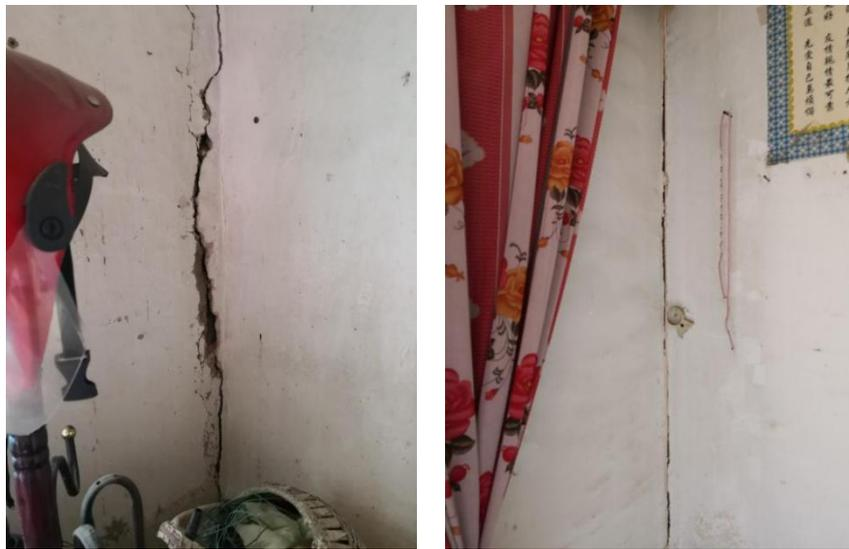
图 3.4.1 (d) 墙体连接处断裂成通缝
