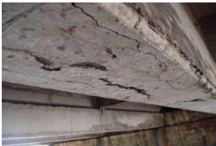
图 3.4.2 (b) 梁底钢筋锈蚀造成胀裂，缝宽大于 1mm
