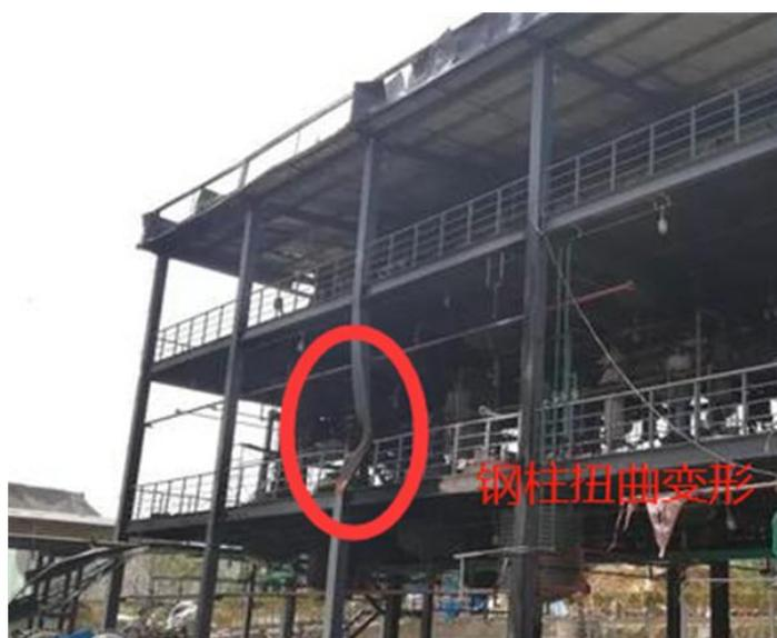
图 3.4.7（a） 钢柱变形较大
