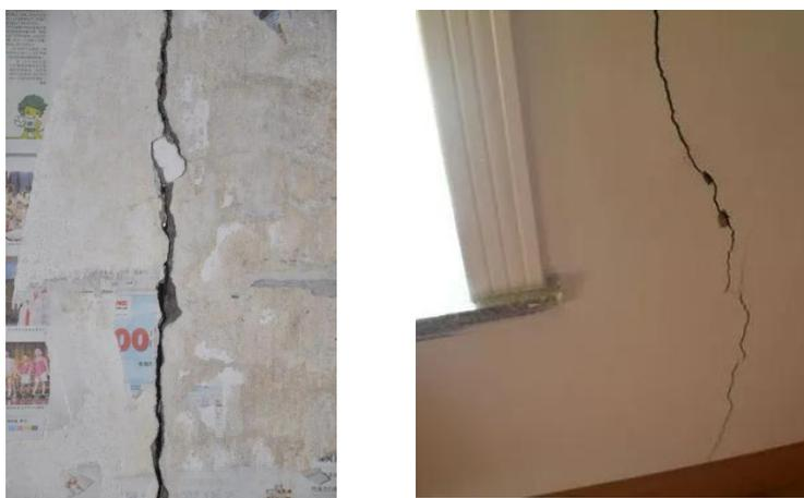
图 3.4.1 (b) 砌体承重墙出现缝宽大于 1mm、缝长超过 1/2 层高的竖向裂缝
