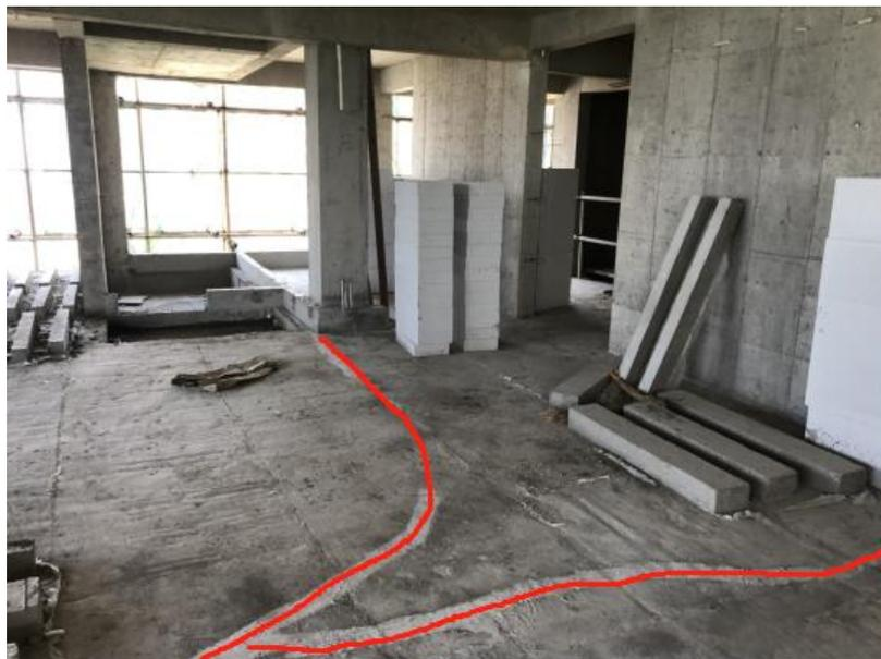
图 3.4.6（b） 现浇板面周边产生裂缝
