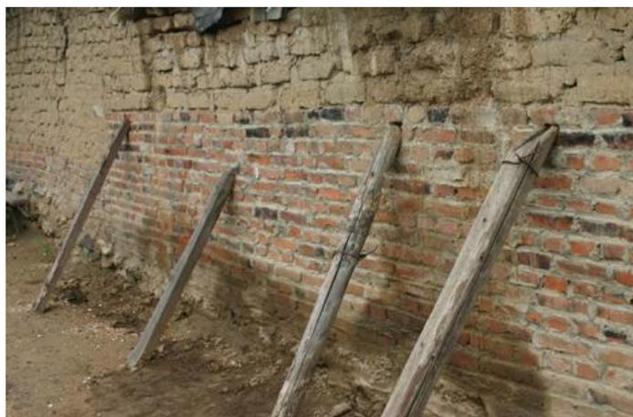
图 3.4.5（a） 承重墙出现侧向变形现象
