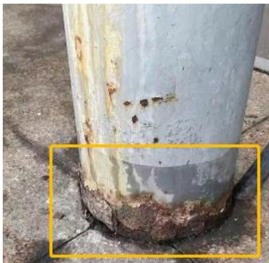
图 3.4.3 (c) 钢柱因锈蚀有效截面削弱 10%以上
