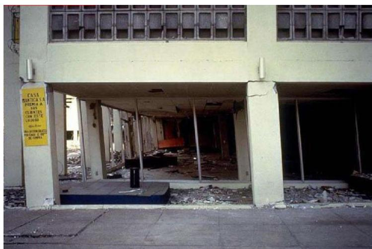
图 3.4.2 (c) 底层框架柱产生明显倾斜，端节点处开裂
