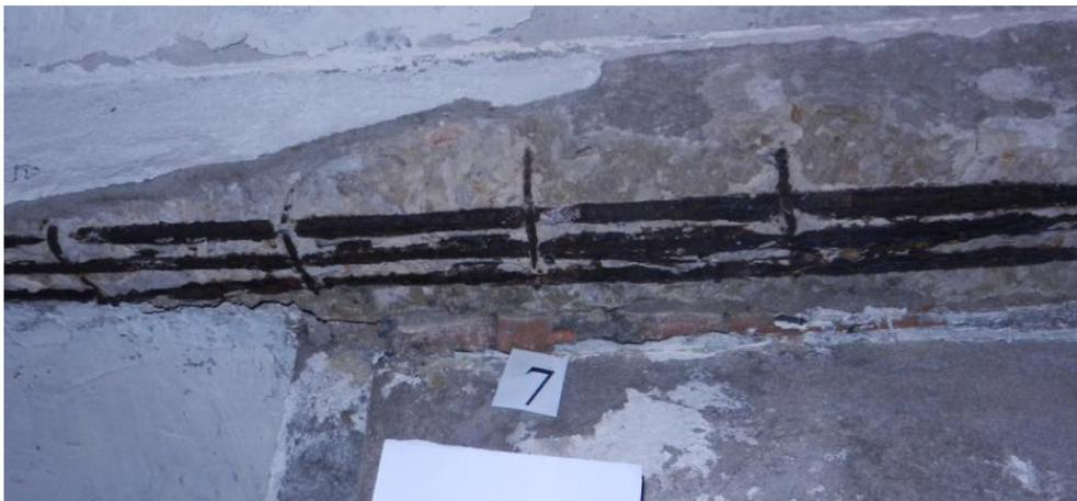
图 3.4.6（a） 梁底钢筋锈蚀、混凝土脱落
