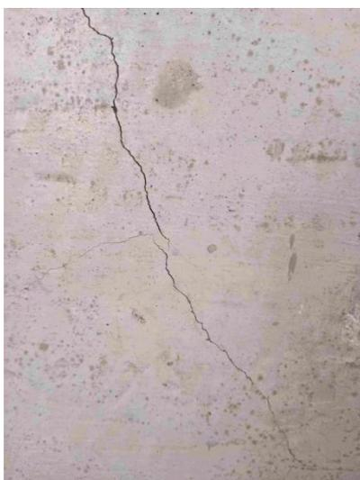
图 3.4.6 (d) 混凝土墙中部产生斜裂缝
