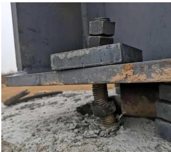
图 3.4.3 (a) 螺栓松动、变形
