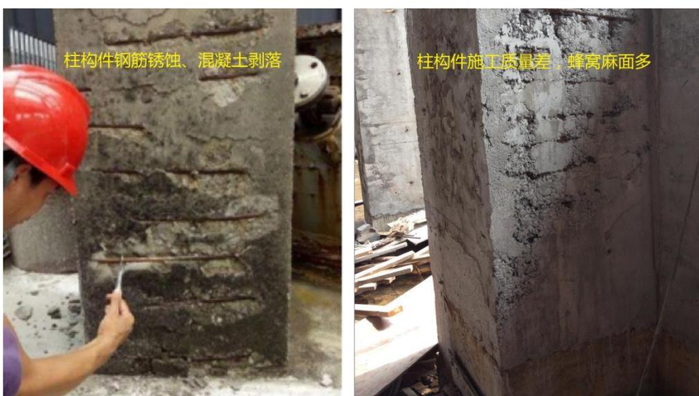
图 3.4.6 (e) 柱构件表面有损伤、缺陷
