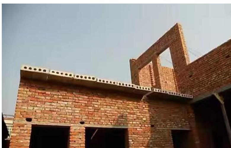
图 3.4.5 (e) 预制板楼屋面，未设置圈梁
