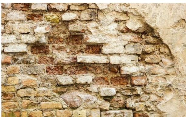
图 3.4.1 (a) 砌体承重墙风化剥落，有效截面削弱 15%以上
