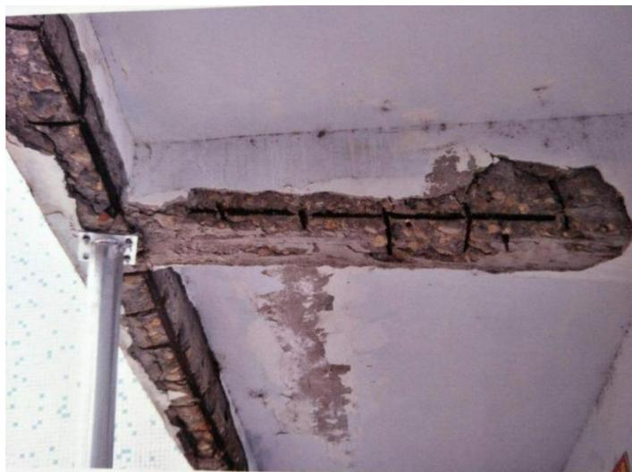
图 3.4.1 (f) 混凝土挑檐的钢筋锈蚀严重、混凝土酥裂分块
